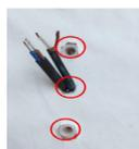
2) Percez deux trous de 6 mm de diamètre et un de 10 mm de diamètre. Ensuite, placez les chevilles dans les 2 trous de 6 mm puis passer les fils à travers le trou de 10 mm de diamètre
